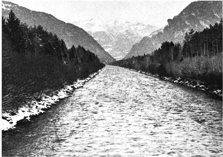
Bild 3 Der Hinterrhein bei Rodels, 1971; Blick flussabwärts, Uferschutz mit Blockwurf.
