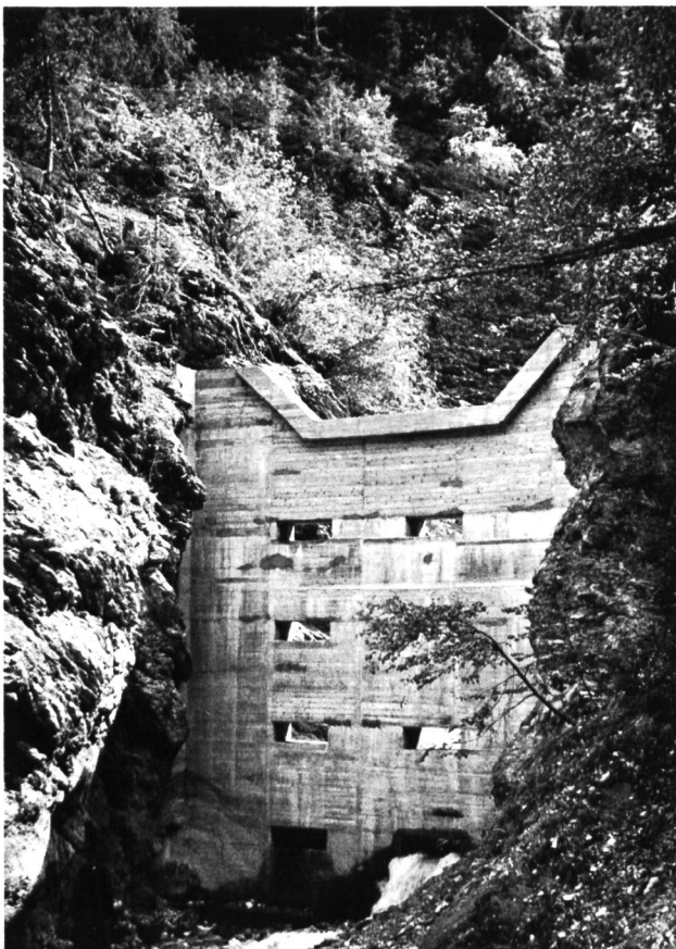
Bild 1 Eine der vielen Betonbogensperren am Rieinertobel, kurz nach der Vollendung im Jahre 1969.
