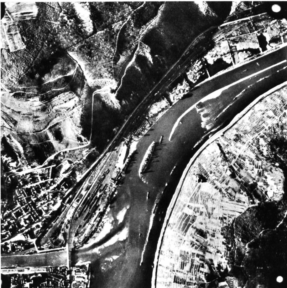
Bild 3 Binger-Loch-Strecke vor dem Ausbau; links unten Einmündung der Nahe.
