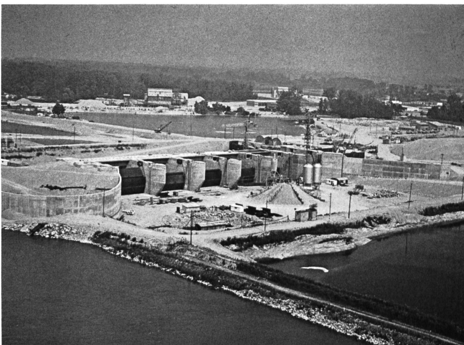
Fig. 12 Aménagement de Gamsheim 1974: Chantier du barrage en rive droite du Rhin.
