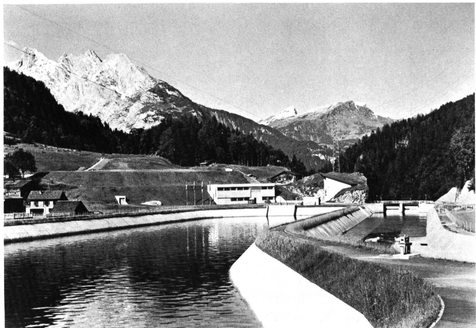
Bild 25 Zentrale, Ausgleichbecken und Wehr Hopflauenen im Gadmental.
