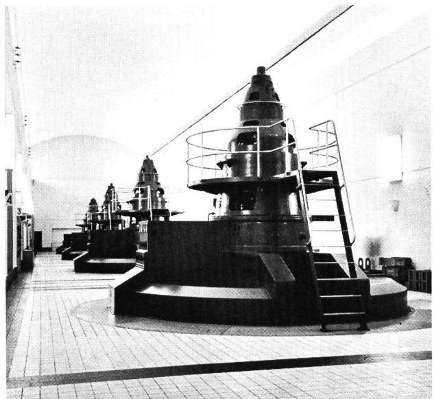
Bild 18 Maschinensaal der Zentralen-Kaverne Handeck II.
