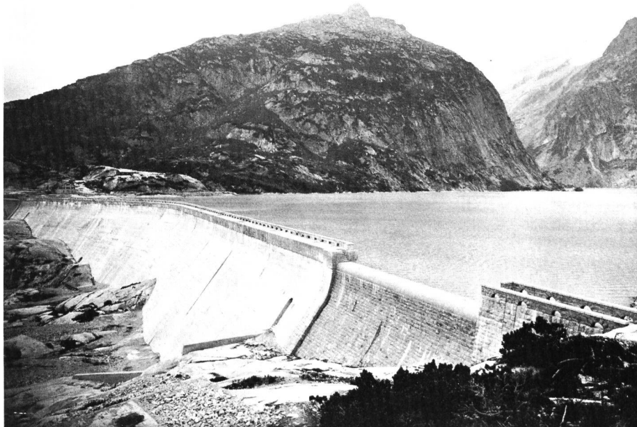
Bild 6 Die 1927/29 erstellte Talsperre Gelmer, eine 35 m hohe Gewicht- staumauer.
