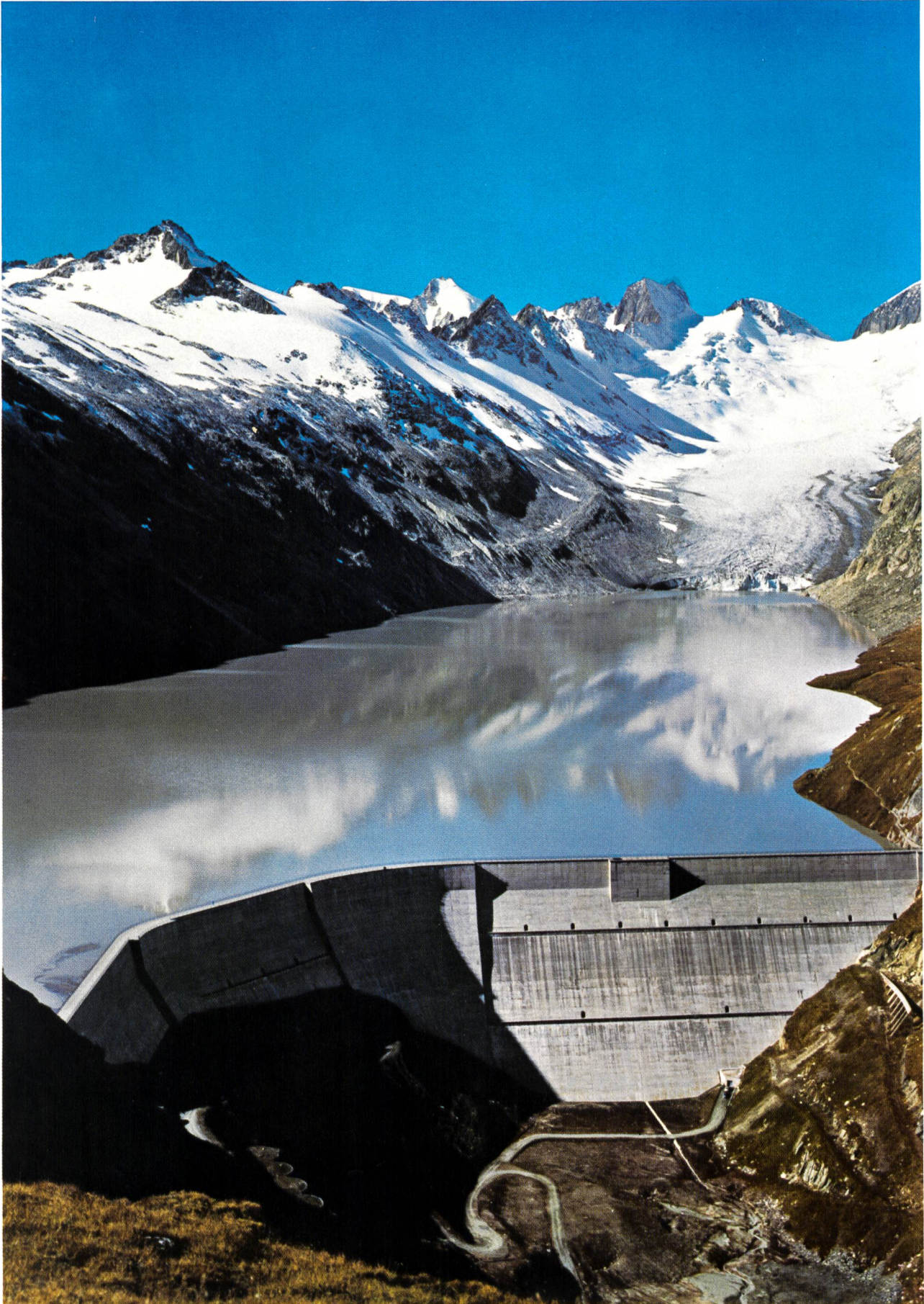
Bild 20 Staumauer und Stausee Oberaar; im Hintergrund das 3638 m hohe Oberaarhorn, mit dem in den Stausee mündenden und kalbernden Oberaargletscher (Foto KWO)
