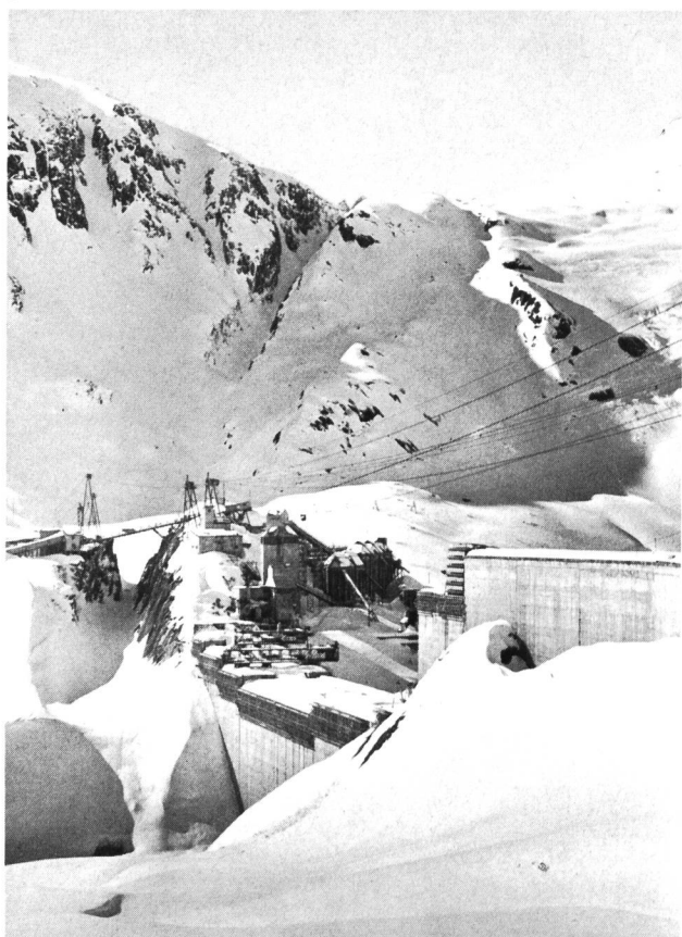
Bild 17 Bau der 95 m hohen Staumauer Räterichsboden, einer Gewichtsstaumauer mit Hohlräumen von 3 m Breite; Blick von der verlegten Grimselstrasse gegen die Betonieranlage (Aufnahme vom 18. Februar 1950).
