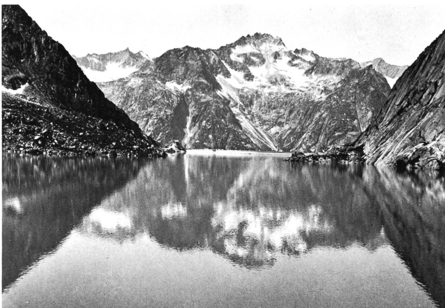
Bild 7 Stausee Gelmer mit Blick gegen Talsperre.
