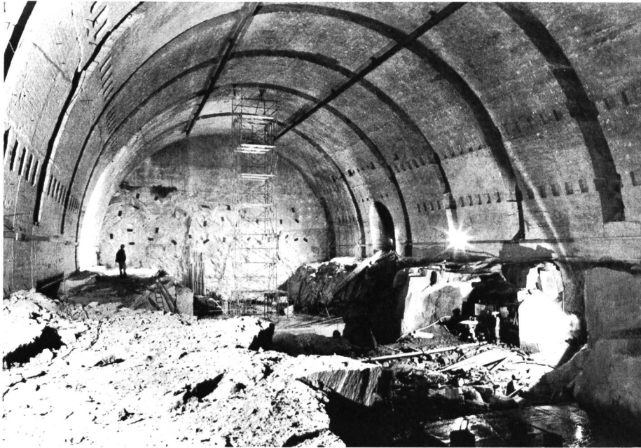
Bild 8 Zentralen-Kaverne Handeck III, Bauzustand Januar 1975.
