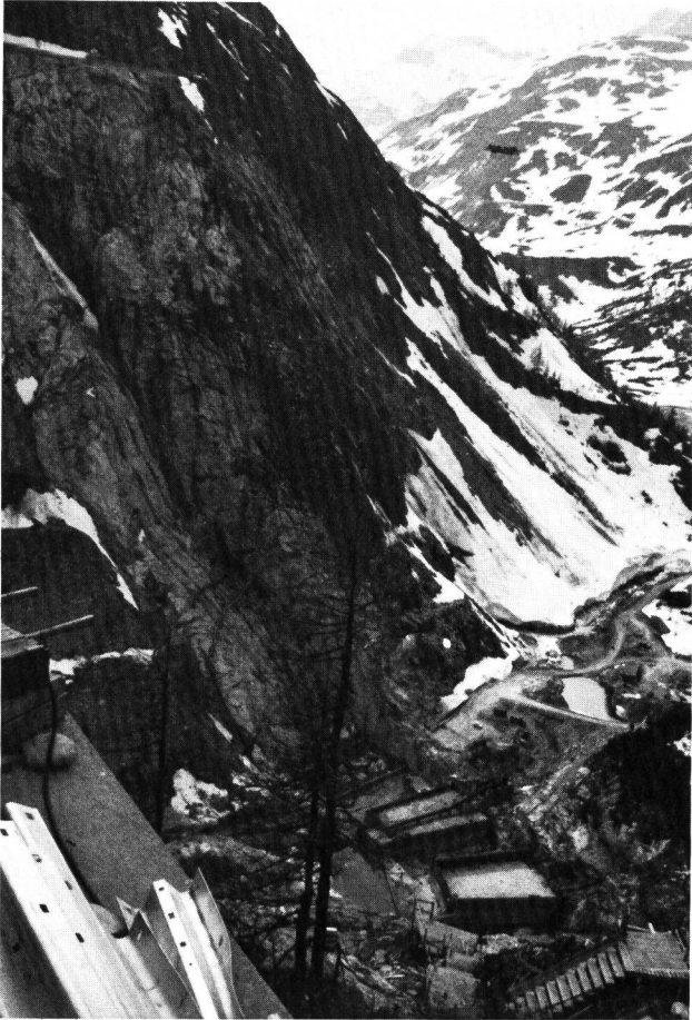
Bild 7 Rechtes Widerlager der Talsperre Sameralm; mit dem Einbringen des Betons ist begonnen worden.
