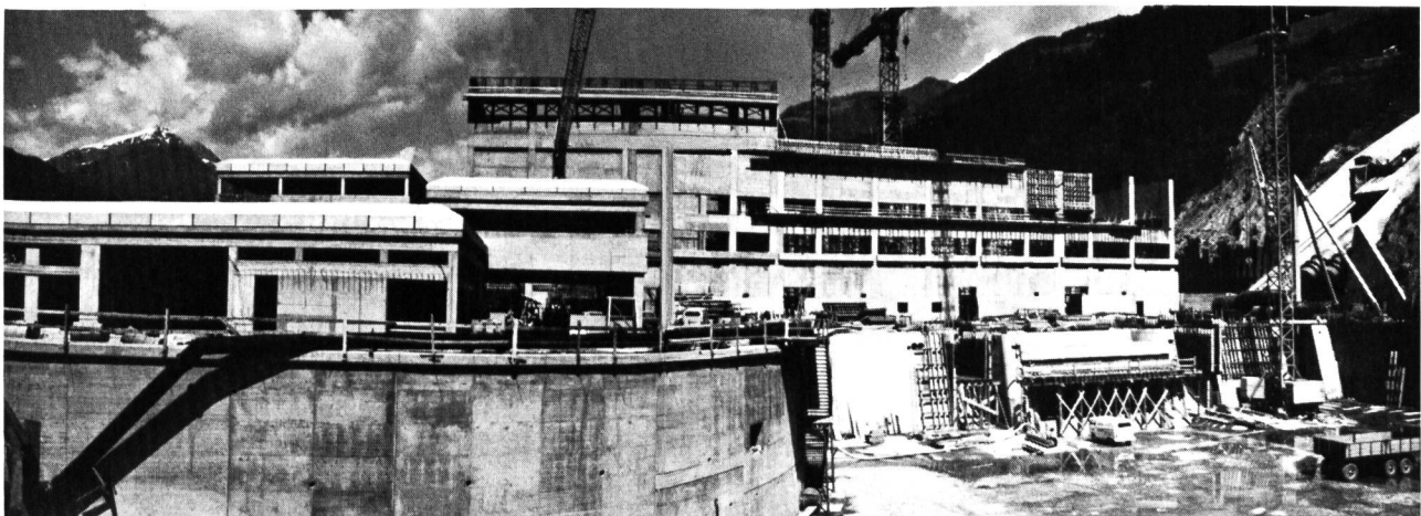
Bild 4 Seitenansicht der Zentrale Rottau bei Mühldorf an der Möll.
