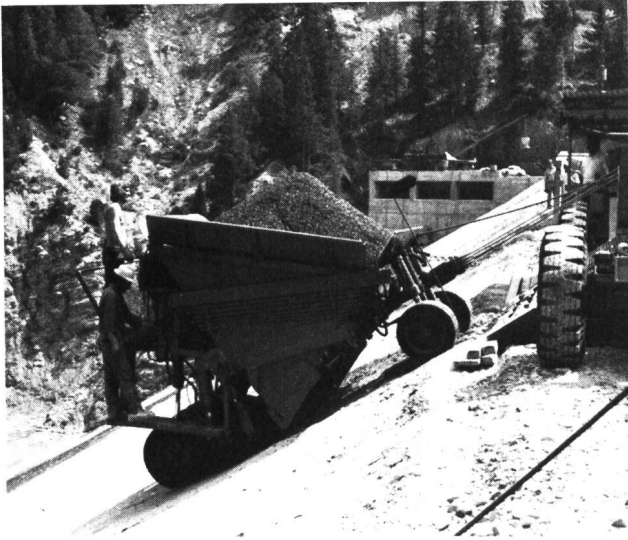
Fig. 3 Mise en place du revêtement bitumineux sur le parement amont de la digue.
