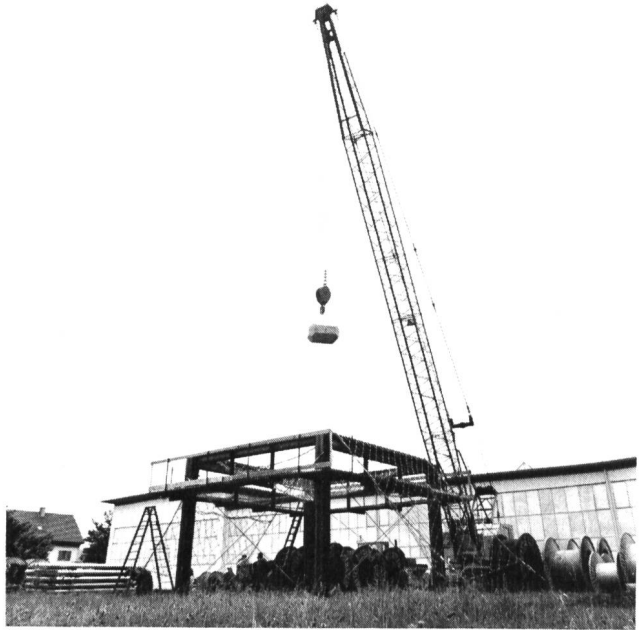
Bild 3 Der eigens dafür gebaute Gerüstbock im Areal der Drahtseilfabrik mit montierten Versuchsnetzen aus Drahtseilen. Das Fallgewicht von 1000 kg wird mit einem fahrbaren Kran auf bis 20 m über die horizontale Netzebene gehoben und ausgeklinkt. Nach jedem Versuch werden alle Veränderungen an Netzen, Seilen, Befestigungen und insbesondere an Bremsselementen protokolliert und ausgewertet.
