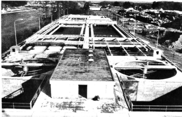
Bild 4 Biologische Abwasserreinigungsanlage, BIKA, Gesamtaufnahme, Anlageblock mit Betriebsgebäude.
