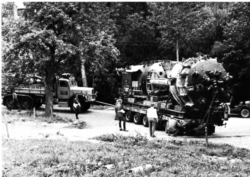
Bild 5. Stollenbohrmaschinen auf dem Weg zur Baustelle.
