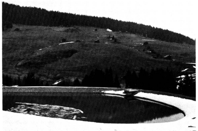
Bild 7 Blick auf das Ausgleichsbecken Gneida (20 000 m 3 Inhalt) mit Einlaufbauwerk.
