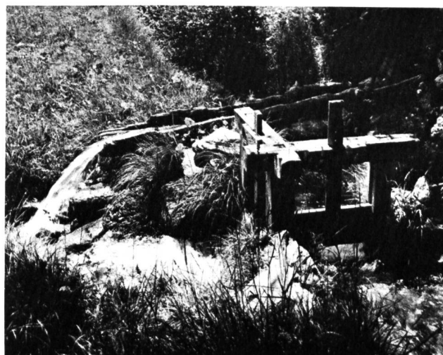
Bild 1. «Les Bisses», Bewässerungssysteme für die Wiesen und Aecker in den Walliser Bergtälern.
