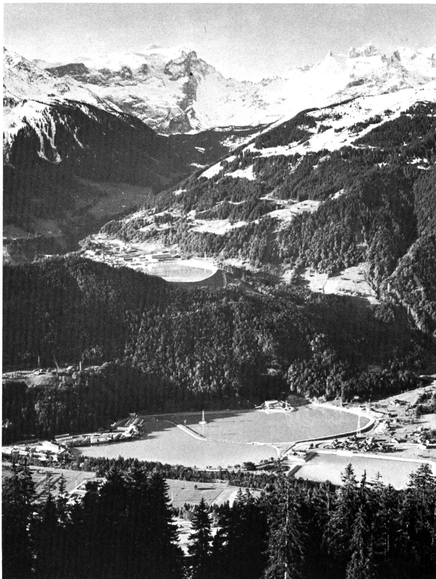
Zum Beschrieb der Kraftwerkgruppe Obere III-Lünersee der Vorarlberger Illwerke AG: Gefällstufe Latschau-Rodund; in Bildmitte Lünerseewerk mit Staubecken Latschau, im Tal Pumpspeicherbecken mit Rodundwerk I und Rodundwerk II.
