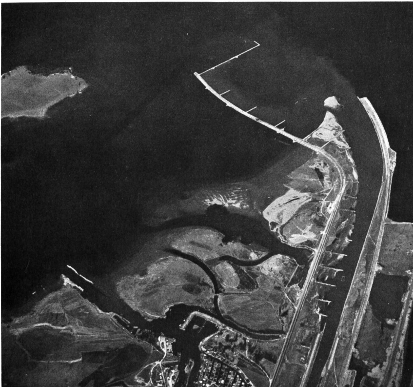
Bild 3. Flugbild der Mündungsbauwerke auf dem Rheindelta im Bodensee, Bauzustand März 1976.
