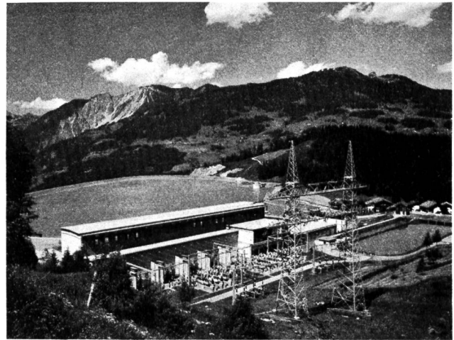
Bild 3. Lünenseewerk mit Latschaubecken I und II; rechts im Bild der Pumpwasserkanal.
