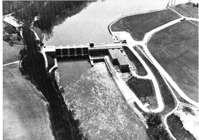
Bild 1. Das Kraftwerk Bremgarten-Zufikon, Ansicht von der Unterwasserseite. (Flugaufnahme Comet)
