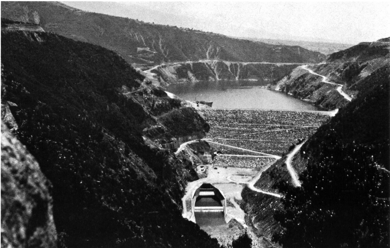
Bild 1. Wasserkraftwerk Polyphyton am Aliachmon in Griechenland. Der Steinschüttdamm von 105 m Höhe staut einen See von rd. 2000 Mio m 3 Inhalt. Die Anlage ist mit 3 Turbinen zu je 120 MW Leistung ausgerüstet.
