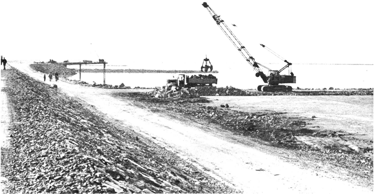
Bild 2. Die Baustellen für die Verlängerungen der Rheindämme konnten anlässlich der Exkursion B nach der Hauptversammlung des Schweizerischen Wasserwirtschaftsverbandes besichtigt werden. (Foto Heinz Wartenweiler)
