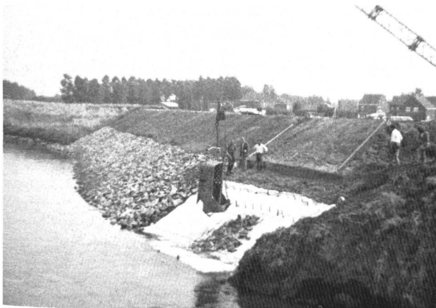
Bild 3. Schütten von Blockmaterial auf das ausgelegte Vlies, das gegen Abrutschen mit Pflöcken gesichert wurde.
