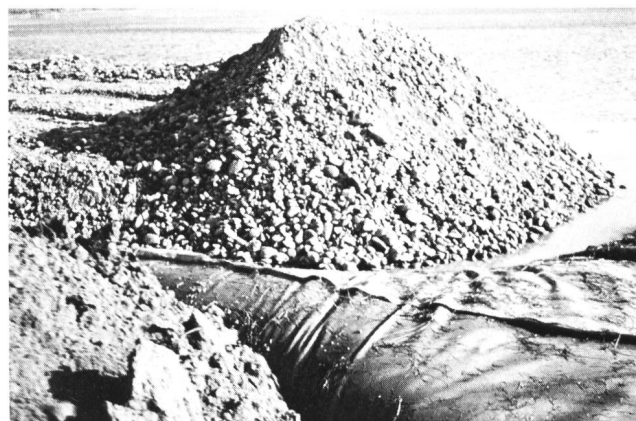
Bild 2. Diese Aufnahme während dem Schüttvorgang zeigt, dass ein solches Vlies sehr starken Zugkräften ausgesetzt wird. Nicht nur die Zugfestigkeit und die Dehnbarkeit des Grundstoffes, sondern auch diejenige der Nähte sind für das Gelingen der Bauvorhaben wichtig.
