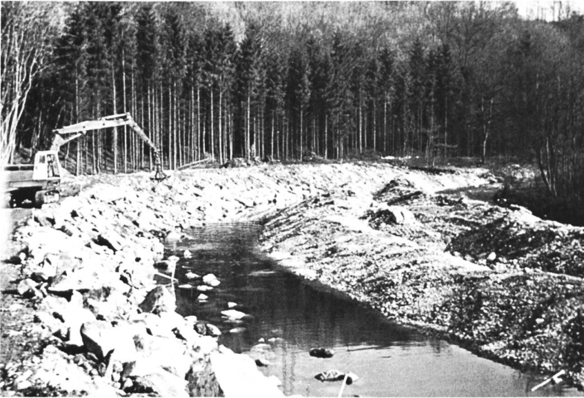
Bild 1, links. Die Glattkorrektur bei Windlisböden, oberhalb Glattfelden. Die Böschung wird mit Bruchsteinen gesichert. Ein Mitteldamm ermöglicht eine Wasserhaltung und das Arbeiten im ruhenden Wasser.
