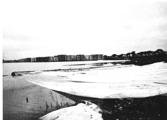
Bild 1. Einschwimmen von Terram-Vliesen 280 als Trennschicht zwischen dem schlechten, schlammigen Untergrund und der Aufschüttung eines Uferdamms. Die Bahnen wurden zu einem grossflächigen Vlies zusammengenäht. Im Hintergrund Fos sur Mer.
