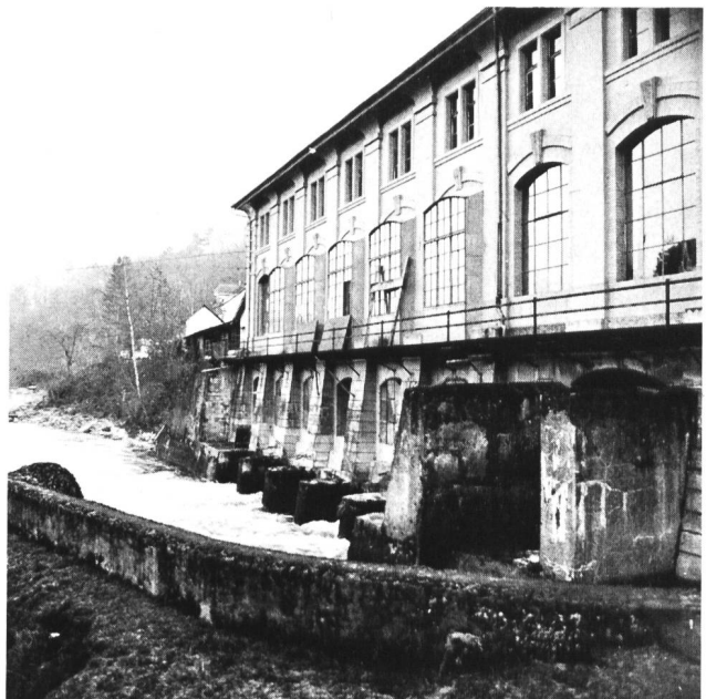
Bild 8. Das alte Maschinenhaus des Kraftwerks Zufikon, das nach 80jährigem Betrieb ausgedient hatte und 1974 stillgelegt wurde. Das Stauwehr und die alte Zentrale wurden abgebrochen und der 350 m lange Zulaufstollen zugemauert.
