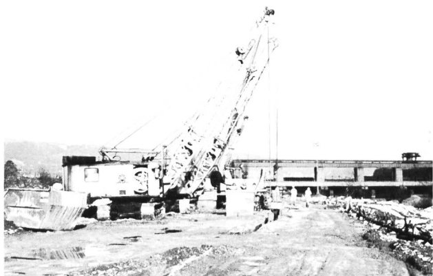
Bild 10. Abteufen der Beckenschlitzwand am 26. Januar 1976.
