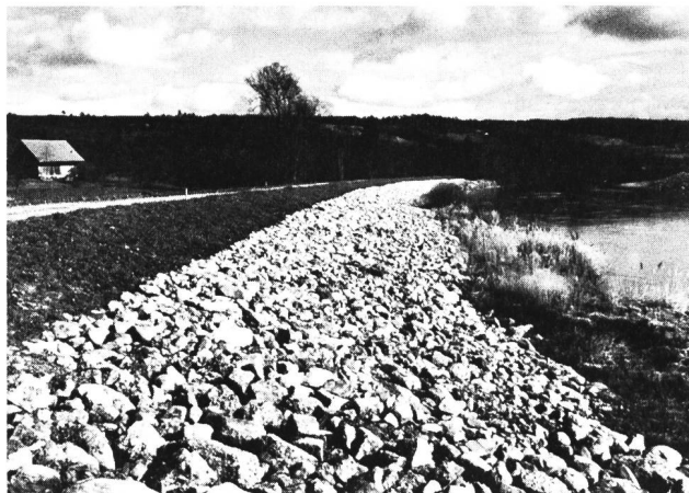
Bild 6. Naturnaher Wasserbau im Gebiet des Geissshofs, Unterlunkhofen: Der Blocksteinwurf des Hochwasserdammes ist (inzwischen eingestaut) kaum mehr sichtbar. (Aufnahme Januar 1975)
