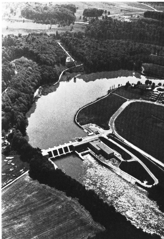
Bild 3. Flugaufnahme der neuen Anlage Bremgarten-Zufikon.
