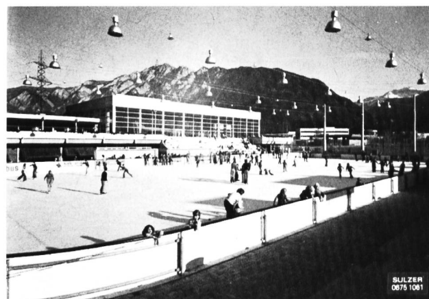
Bild 1. Sportzentrum Obere Au in Chur (CH) mit Kunsteisbahn und Hallenbad im Hintergrund.
