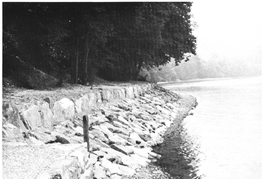
Bild 8. Teststrecke bei Rheinklingen 1976. Bild der fertigen Versuchsböschungen.
