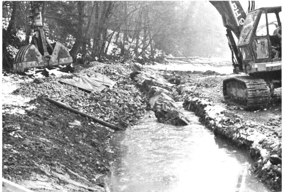
Bild 6. Teststrecke bei Rheinklingen, Variante A während des Baus.
