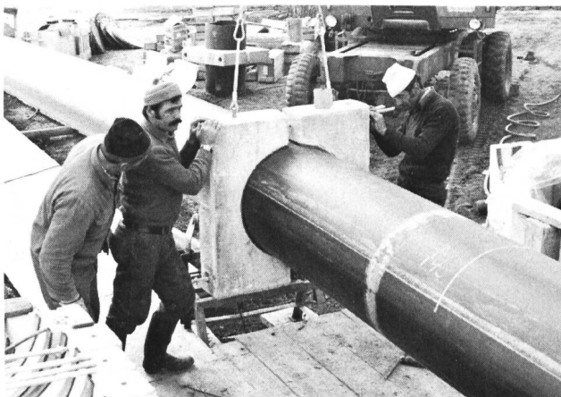
Bild 4. Montage der Beschwerungsklötze.
