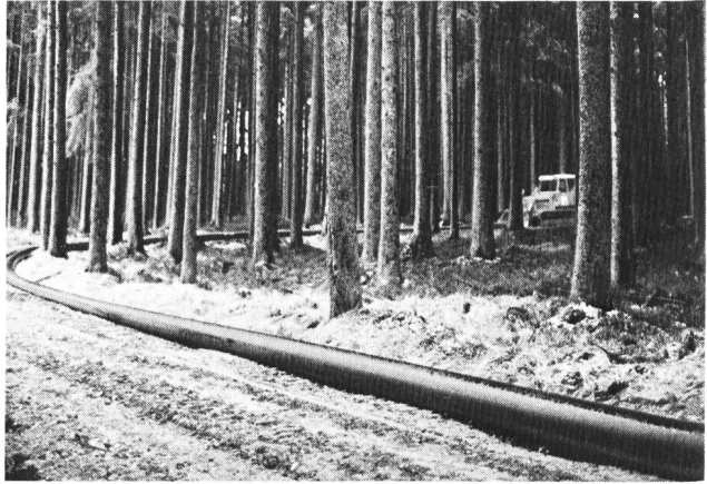
Bild 4. Transport zur Verlegestelle.
