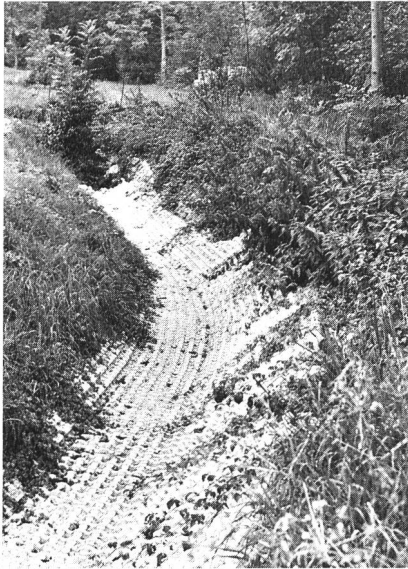
Bild 3. Die UK-Bachverbauung passt sich dem Gelände an.
