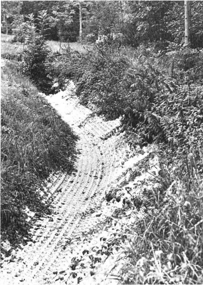
Bild 3. Die UK-Bachverbauung passt sich dem Gelände an.
