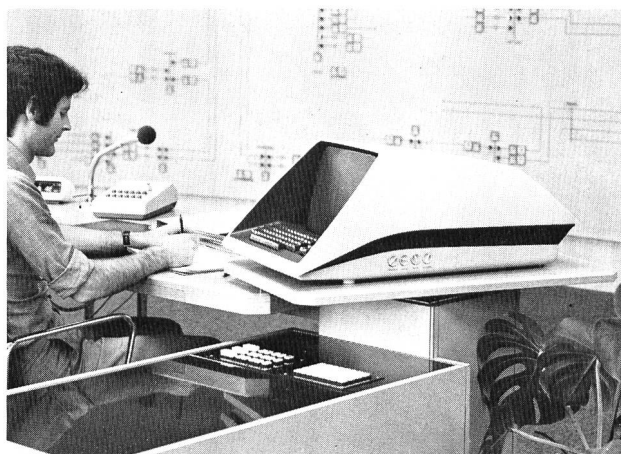
Kommandoraum mit Display, Betriebsschaubild und Konsole der Automatisierungsanlage für ein Wasserkraftwerk. (Foto: Brown Boveri)
