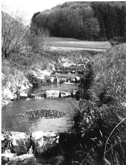
Bild 3, rechts. Sperrentreppen im steilen, stark erodierten Gerinne, Oberlunkhofen, 1975.
