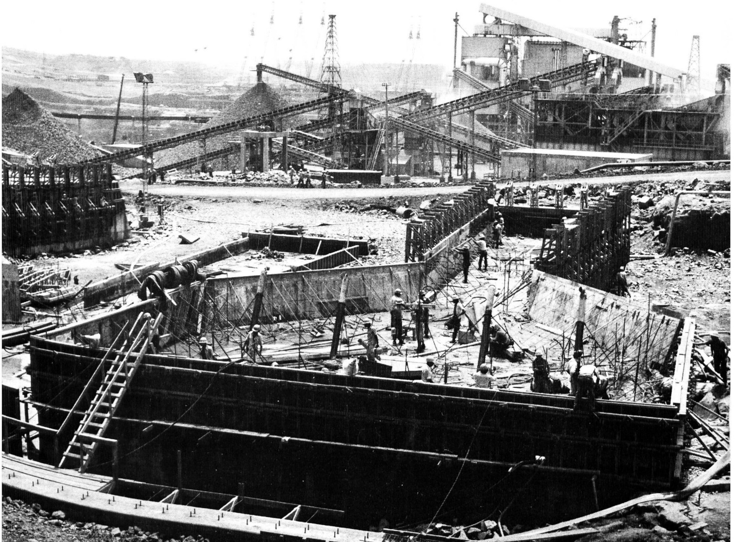
Bild 6. Betonierarbeiten an Pfeiler der rechtsufrigen Seitenmauer.
