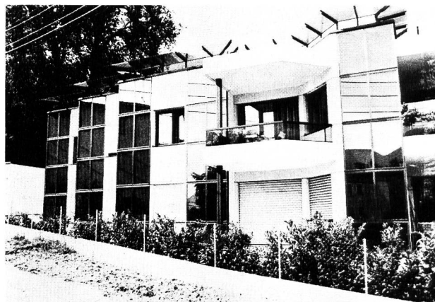
Bild 3. Ein Teil der Südfassade des Hauses mit eingebauten Sonnenkollektoren. Die auf dem Dach montierten, geneigten Sonnenkollektoren für die Warmwasserversorgung sind nicht sichtbar.
