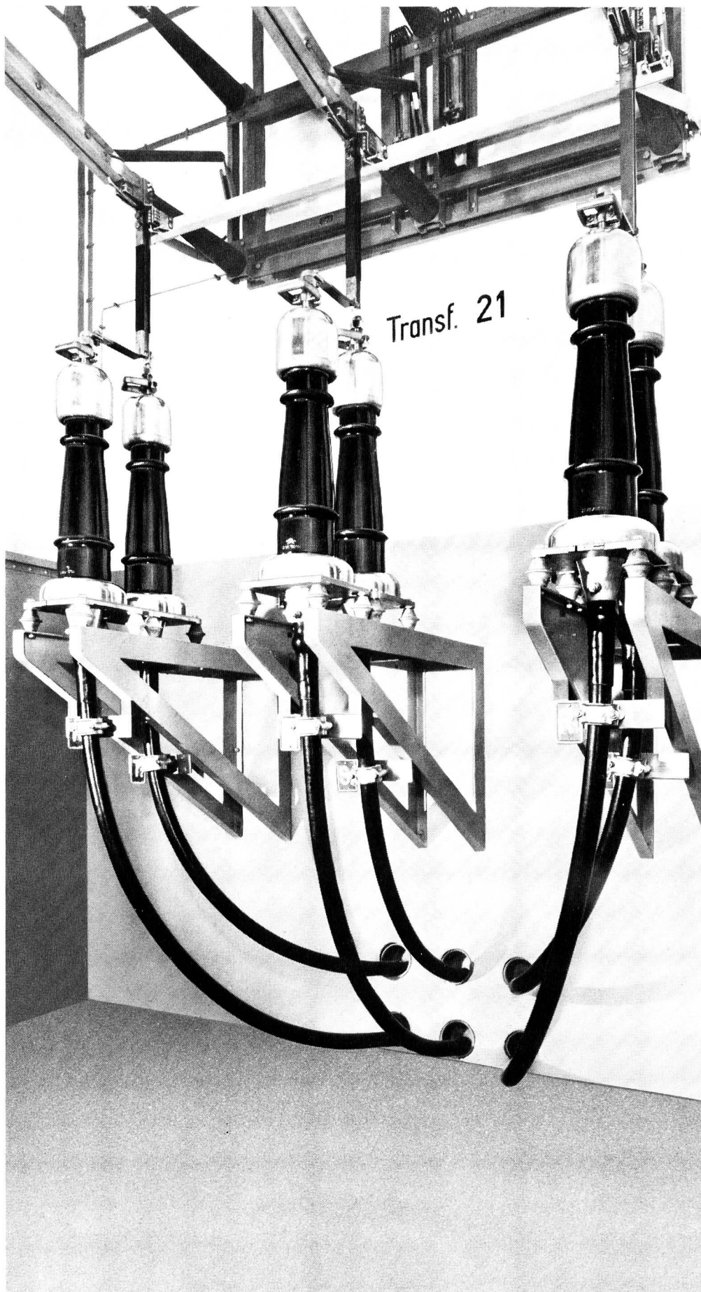
60 kV Einleiter-Oelkabel 1 \times 800 \text{ mm}^2 mit Innenraum-Kabelendverschlüssen als Verbindungsleitung zwischen Schaltanlage und Transformator in einem Unterwerk 220/60 kV
