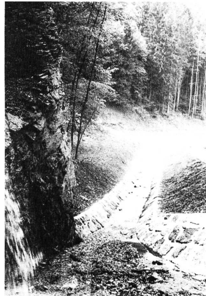
Bild 4. Rechts der Saarfall, links der Wasserfall der Kleinen Saar, während deren Umleitung für den Bau des Verbindungsgrabens in den Kiesfang des Saarkanal. So existierten hier während der Bauzeit vorübergehend zwei imposante Wasserfälle. Absperrmauer des Kiesfanges, Tosbecken und oberster Teil des neuen Saarkanal.
