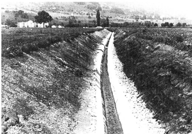
Bild 5. Entwässerungsgraben mit Betonsohle. Bei geringem Gefälle musste diese Bauweise angewendet werden, während bei allen grösseren Kanälen eine Kiessohle vorgesehen wurde und die Ufer mit Natursteinpflasterung gesichert wurden.
