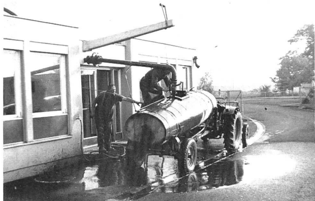
Bild 8. Faulschlammabfuhr. Figure 8. Ependage de boues.
