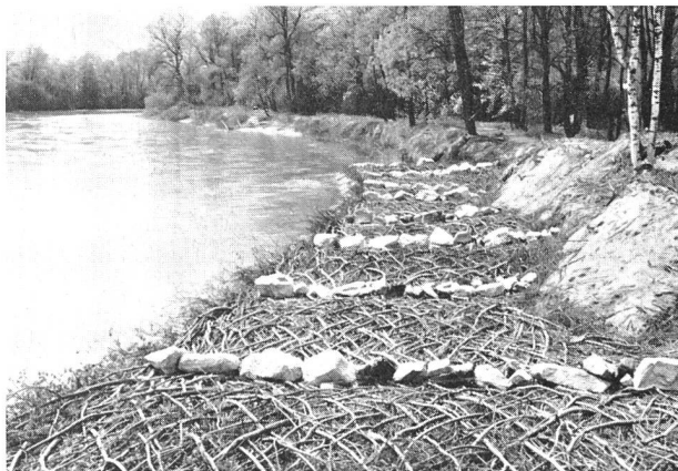
Bei der Gitterbauweise an der steirischen Enns werden nach ingenieurbio-logischen Erkenntnissen Pflanzen als «Lebendverbauungen» der Flussufer eingesetzt. Die Stecklinge beginnen bereits auszuschlagen.
