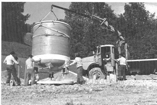
Bild 6. Einbau eines Lysimeters für genaue Verdunstungsmessungen im hydrologischen Testgebiet Rietholzbach (SG).
