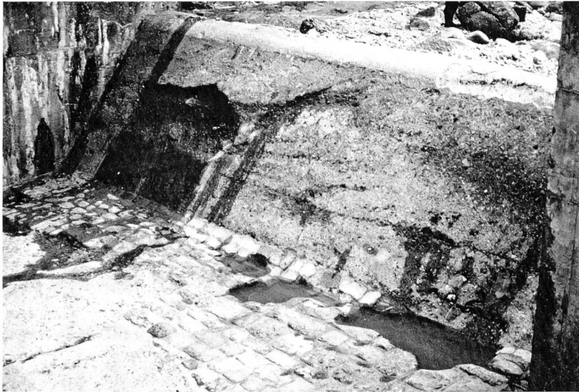
Bild 2, links. Unterwasserseitige Ansicht der festen Wehrmauer der Wasserfassung Trepsenbach mit Frostschäden, Durchsickerungen und zerstörter Sohlenpflasterung durch Kolkwirkung. Oberhalb der Wehrkrone ist die vollständige Auflandung des Stauraumes zu erkennen.
