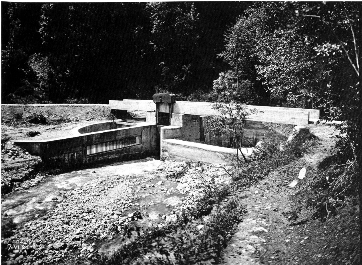
Bild 1. Oberwasserseitige Ansicht der alten Wasserfassung Trepsenbach im Juni 1924, mit fester Wehrmauer, Grundablass und Einlauf zum Entkieser.
