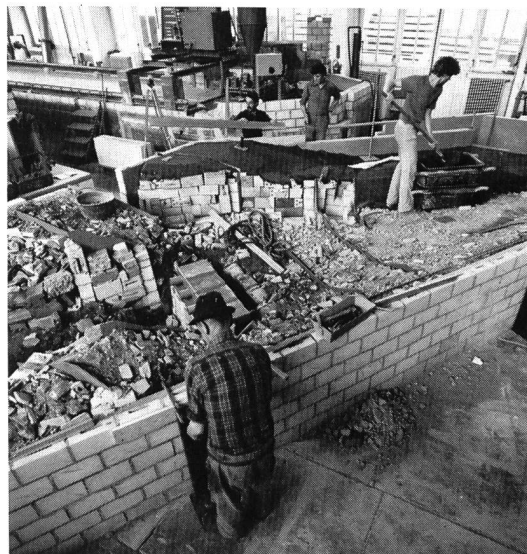
Bild 1, links. Erstes, im Jahre 1930 erstelltes Modell in der Versuchshalle der VAW: Nachbildung des Stauwehres des Limmatwerkes Wettingen im Massstab 1:40.
