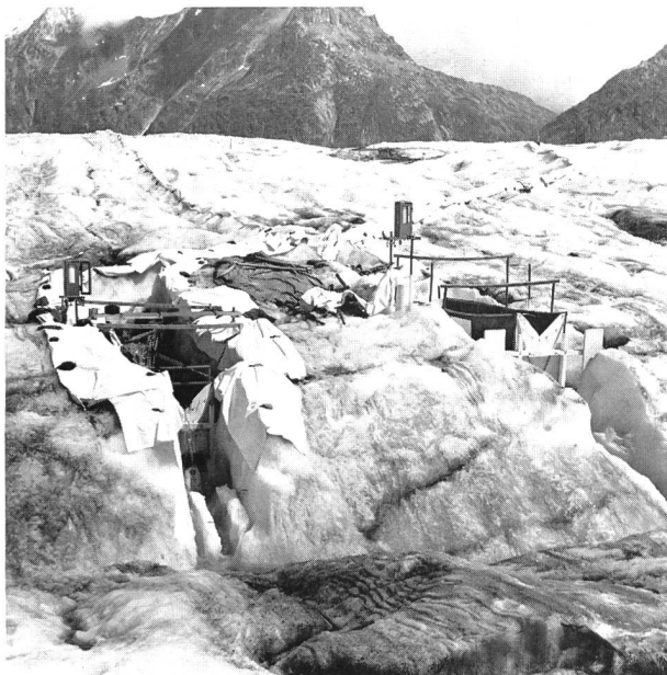
Bild 7. Die Einrichtung und der Betrieb einer Station zur Abflussmessung am grossen Aletschgletscher waren technisch schwierig, weil sich die Eisoberfläche durch Ablation und Eisbewegung dauernd veränderte. Nach etwa 2 Wochen Schmelzperiode war die Station rechts im Bild unbrauchbar; an einer inzwischen vorbereiteten zweiten Station konnte die Limnigraphenregistrierung ohne Unterbrechung fortgesetzt werden. Das weisse Syntosilpapier, von dem ein 30 cm breites Band um das ganze Versuchsgebiet ausgelegt worden war, dient zum Schutz vor der Sonnenstrahlung, um die Ablation möglichst gering zu halten. Gleichzeitig dient es zur Abgrenzung des zirka 4500 m 2 grossen Einzugsgebietes, in dem im Sommer 1965 gleichzeitig zur hydrologischen Bilanz die Wärmebilanz und die Eisablation erfasst wurden.
