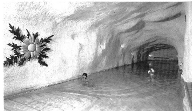
Bild 13: Mit Spritzbeton abgedichtetes Gewölbe und Becken eines Kavernenbades in Zermatt, Wallis. (Foto H. Germond, Lausanne)
