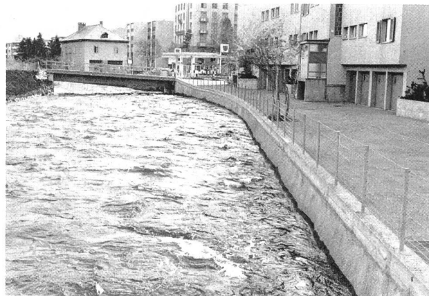
Bild 1: Mit Spritzbeton verstärkte Ufermauer aus Natursteinmauerwerk in St. Moritz-Bad.
