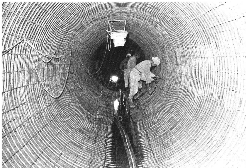
Bild 14, links: Mit Spritzbeton ausgekleideter Freispiegelstollen (Widerlagerbereich geglättet), Nesselental (Kraftwerke Oberhasli AG).
