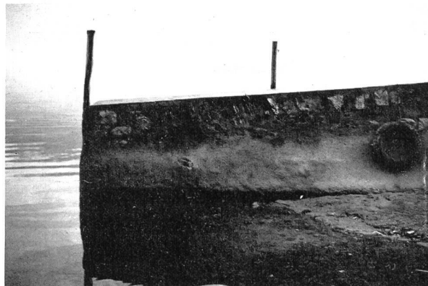
Bild 2: Mit Spritzbeton verfestigte Hafenummauerung aus Natursteinmauerwerk in Porto Ronco, Tessin.
