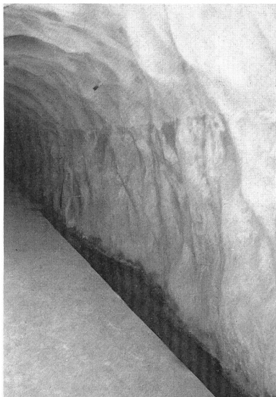
Bild 14, links: Mit Spritzbeton ausgekleideter Freispiegelstollen (Widerlagerbereich geglättet), Nesselental (Kraftwerke Oberhasli AG).
