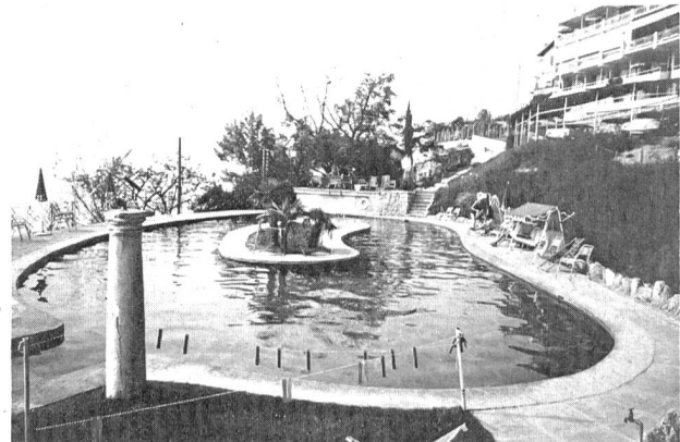
Bild 5: Nierenförmiges Schwimmbassin mit Insel, beide aus Spritzbeton (Alde-sago, Tessin).
