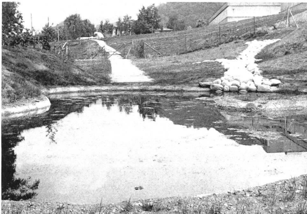
Bild 7: Lehrweiher aus Spritzbeton in Savosa, Tessin.
