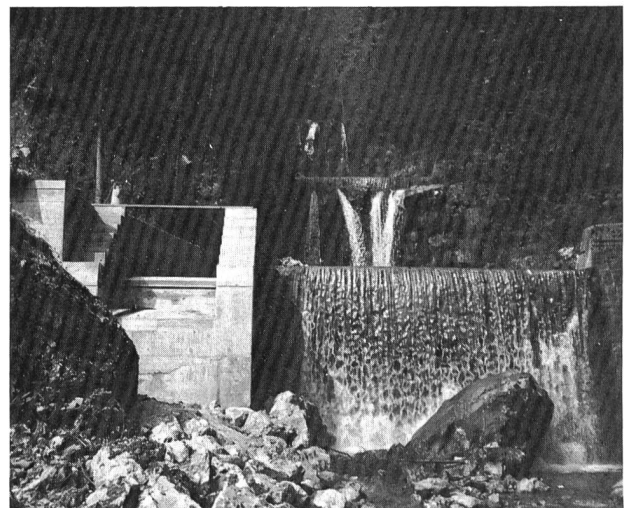
Bild 4. Erneuerung der Kraftwerkanlagen Niederurnen. Die Tirolerfassung Morgenholz vom Unterwasser her gesehen. Der Rechen ist noch nicht eingebaut. Foto J. L. Mottier, Oberrohrdorf
