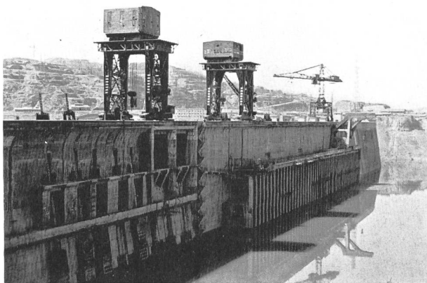
Bild 7. Aufnahme der Staumauer von der Oberwasserseite. Der Wasserstand entspricht dem maximalen Stauziel nach der Sanierung.
