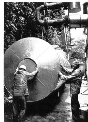
Die Aufstellung der neuen, grösseren Verbrennungsanlage bei der Druckerei Herzberg. Deutlich erkennt man die engen Platzverhältnisse, da die Aufstellungsfläche auf einer Seite vom Gebäude und auf der anderen Seite durch einen Bahndamm begrenzt ist.
