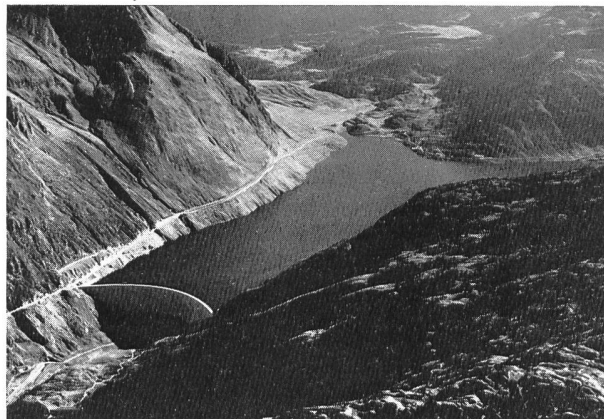
Bild 1. Kraftwerke Vorderrhein, Stausee Sta. Maria mit Lukmanierpass.
