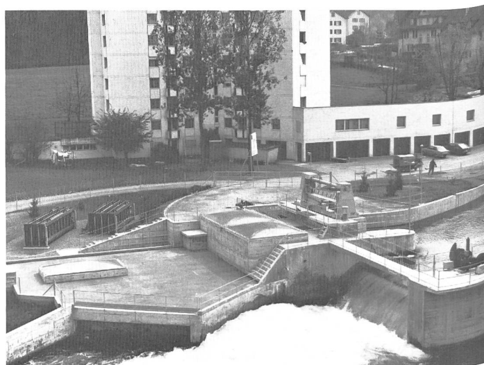
Bild 1. Die neue unterirdische Turbinenanlage Perlen an der Reuss mit automatischer Stauklappe, Turbinenauslass, Rechenreinigungsanlage und Damm-balkenlager.
