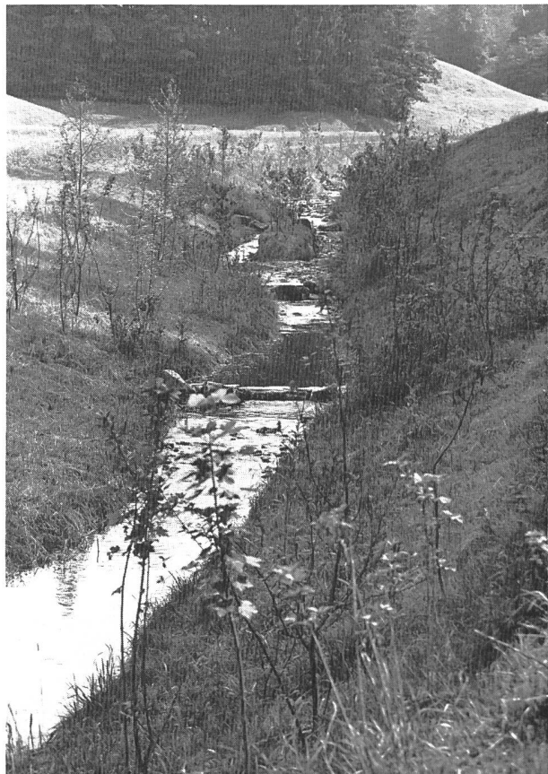
Bild 1. Vergleich eines konventionellen Ausbaues mit dem heutigen Ausbau. Der Mehrbedarf an Land beträgt im Mittel 1,2 m.
