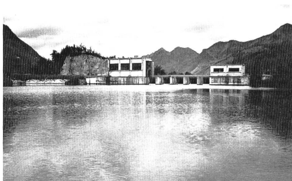
Figure 5. Vue du barrage de Lessoc, depuis l'amont.
