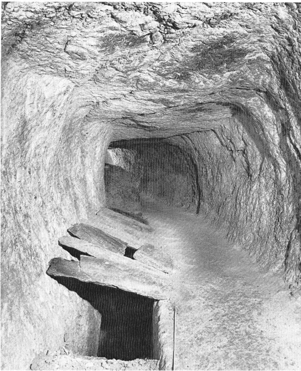
Bild 9. Eupalinostunnel, Samos. Mit Schistplatten, abgedeckter Rohrgraben. Im Hintergrund abgelagerter Einschwemmbo den.
