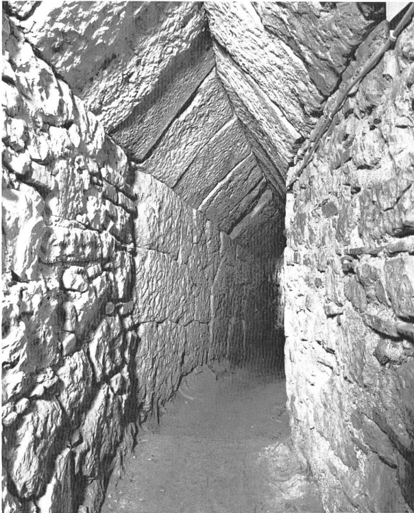
Bild 4. Eupalinostunnel auf Samos. Archaischer Spitzgiebelbau am Südeingang.
