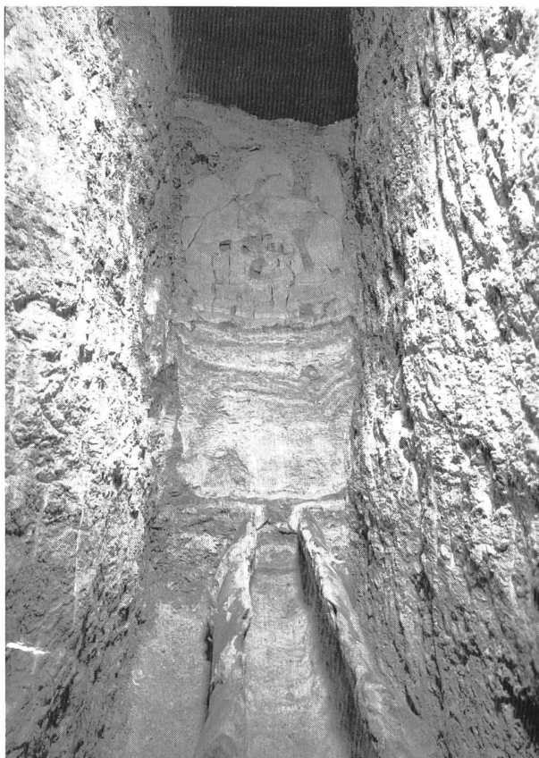
Bild 8. Eupalinostunnel, Samos. Rohrgraben mit aufgeschlagener Tonrohrleitung, Sinterablagerungen und Bodeneinschwemmungen.
