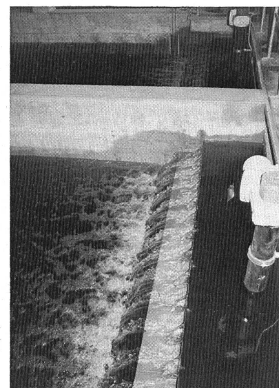
Bild 1, links. Abwasserfiltrationsanlage der Stadt Uster. Im Vordergrund Belüftungs- und Nachklärbecken der zweiten Anlage.
